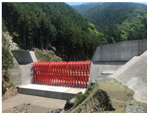
黒滝村赤滝 黒滝川3号砂防堰堤
