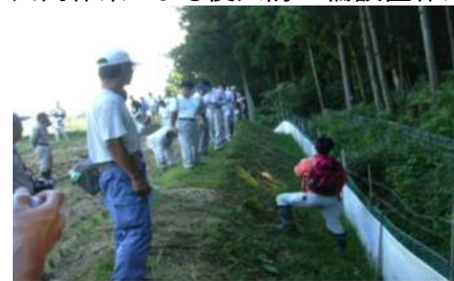
共同作業による侵入防止柵設置作業
