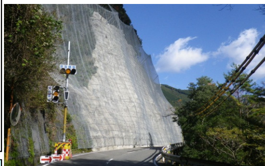
道路防災対策(一般国道168号)
