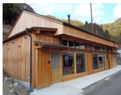
宿泊施設に改修 【旧武蔵小学校の教職員住宅(十津川村)】
