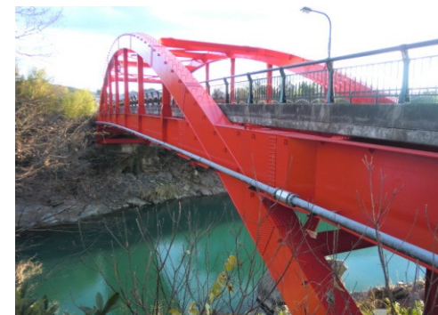
橋梁の長寿命化 (一般県道平原五條線:栄山寺橋)
