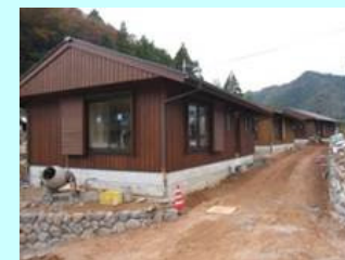
十津川村公営復興住宅
