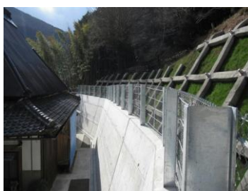
急傾斜地崩壊防止施設
