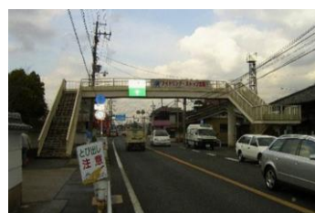
歩道橋 (都跡歩道橋)
