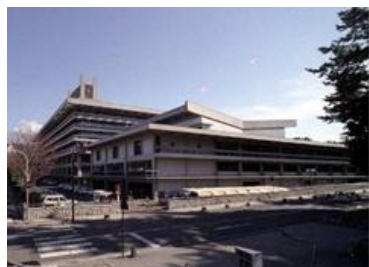
庁舎系施設 (県庁舎)
