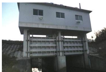
樋門 (小金打川逆流防止樋門)
