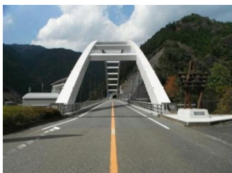
橋梁 (宇井大橋)
