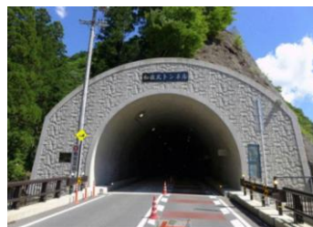
トンネル (和佐又トンネル)
