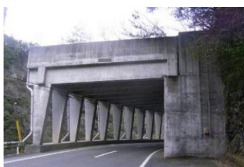
ロックシェッド (芦廻瀬洞門)
