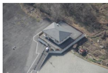
ポンプ場 (野原ポンプ場)
