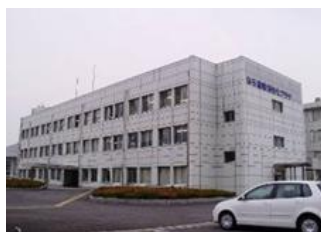
研究・検査施設 (産業振興総合センター)
