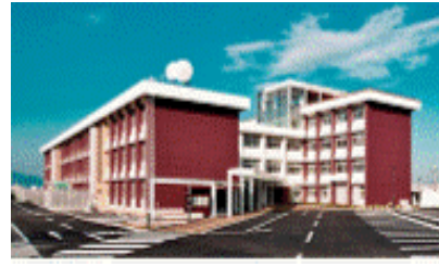
集約化した庁舎 (櫃原総合庁舎)
