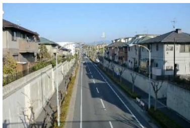
郊外戸建住宅地
