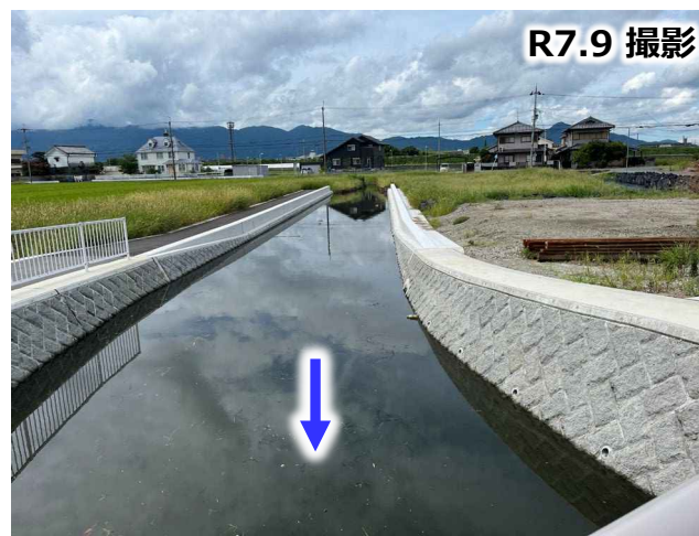
無名橋④上流（改修中）
