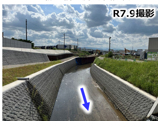
小柳小橋上流（改修中）
