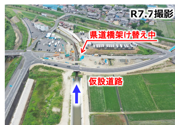
県道橋架け替え（改修中）
