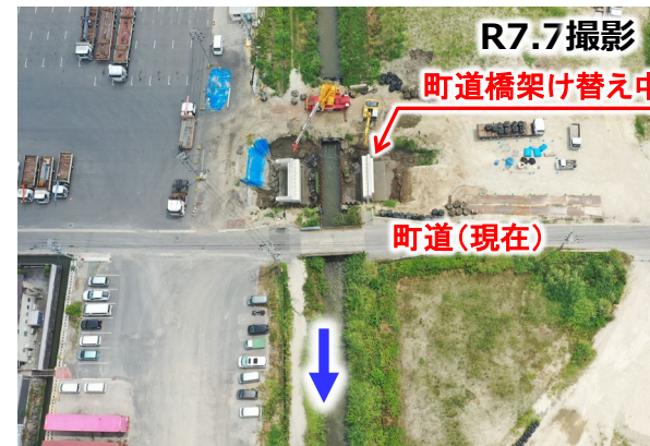
町道橋架け替え（改修中）
