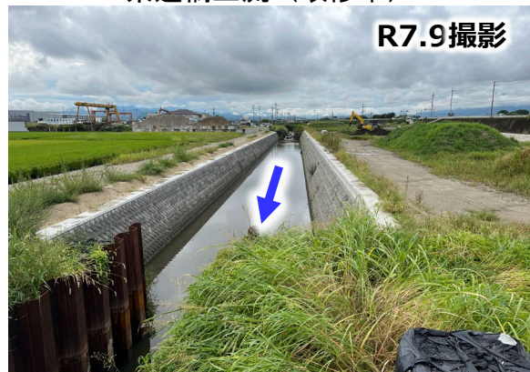
県道橋上流（改修中）
