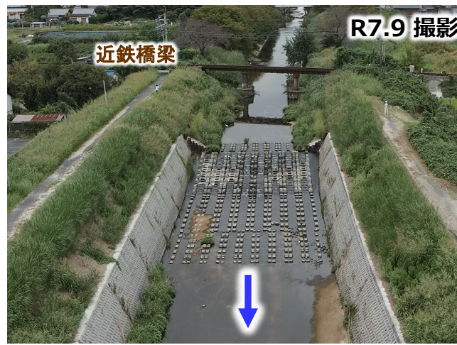
近鉄橋梁下流（一部未改修）
