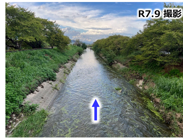
里合橋下流（未改修）
