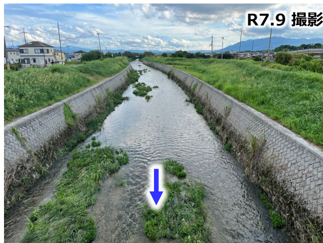
新橋上流（改修済）
