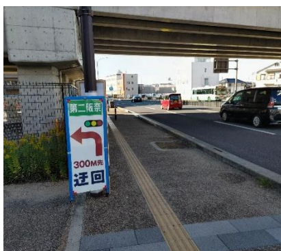
図 6.14 迂回誘導看板の設置
