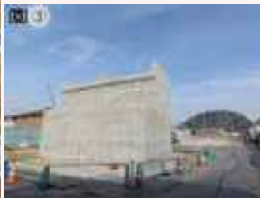
▲ランプ橋橋台工事 (令和8年2月時点)
