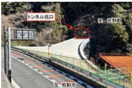
▲工事の様子 令和8年1月 撮影
