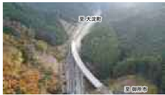
▲工事の様子 令和7年12月 撮影
