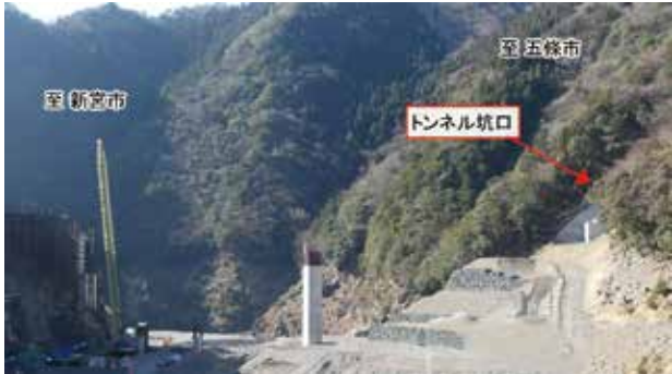
▲工事の様子 令和8年1月 撮影
