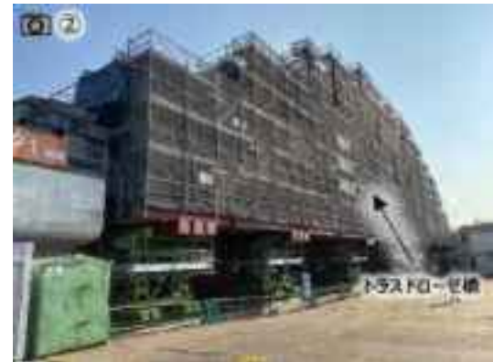
▲JR関西本線高架化工事 (令和8年2月時点)
