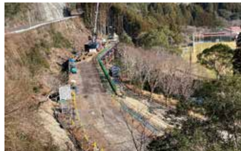
▲工事の様子 令和8年1月 撮影
