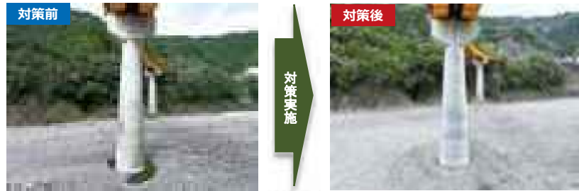
▲橋脚巻立て工による耐震補強工事（一般国道168号 小原大橋）
