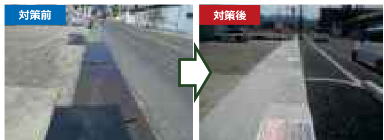
▲歩道設置（国道166号 葛城市尺土）
