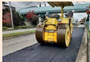
▲舗装補修 (中和幹線)
