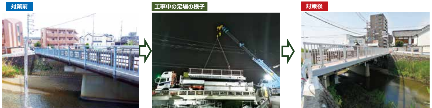
▲橋梁の架替工事 (一般国道169号 磐余橋)
