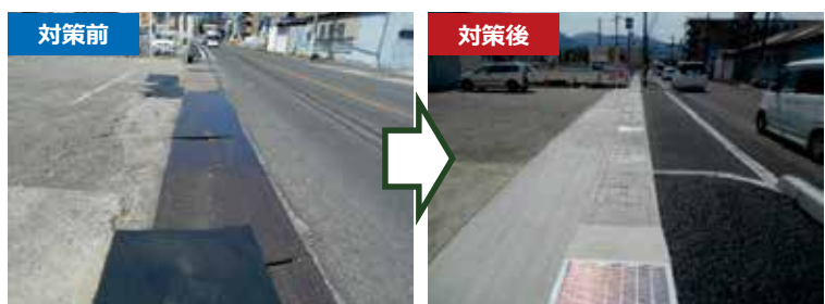
▲歩道設置（国道166号 葛城市尺土）
