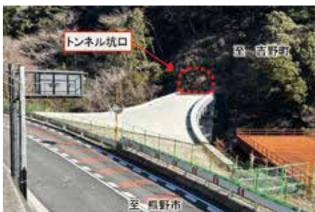
▲工事の様子 令和8年1月 撮影
