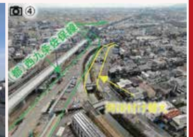
▲河川付け替え工事(令和8年2月時点)
