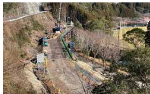
▲工事の様子 令和8年1月 撮影
