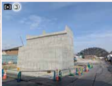
▲ランプ橋橋台工事(令和8年2月時点)
