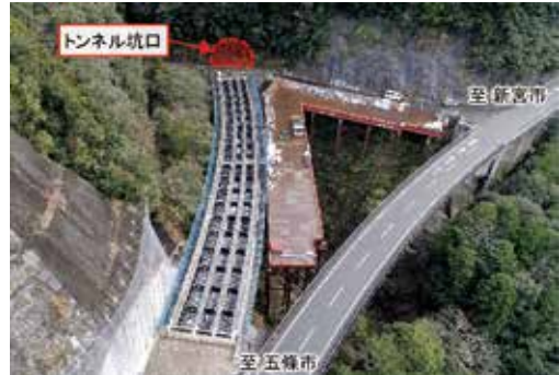
▲工事の様子 令和8年1月 撮影
