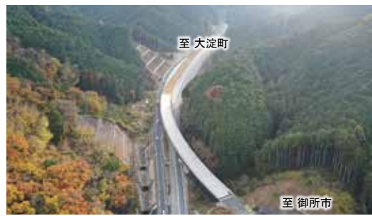
▲工事の様子 令和7年12月 撮影
