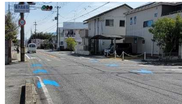
▲自転車通行空間(車道混在)
